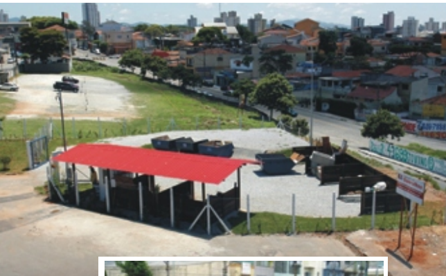
Instalação pública para atração de pequenos volumes de RCD
