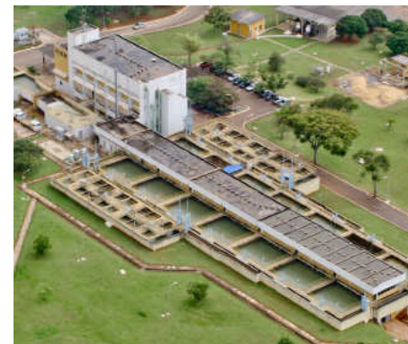
ETA Rio Descoberto
