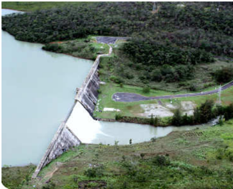
Barragem do Descoberto
